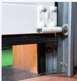
Particolare guarnizioni di tenuta.
